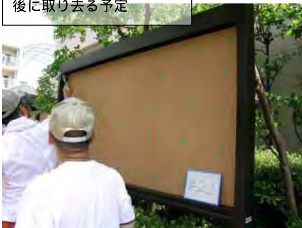
仮止めピンは接着剤固化 後に取り去る予定
